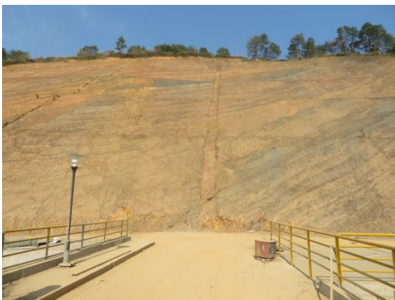
正在施工中的左岸边坡
