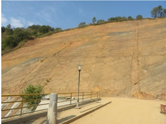
正在施工中的左岸边坡
