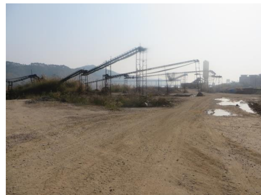
施工辅助设施及生活区
