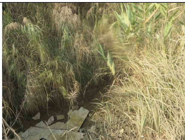
弃渣场土质排水沟
