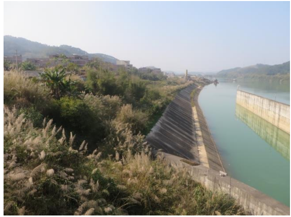
右岸边坡浆砌石防护
