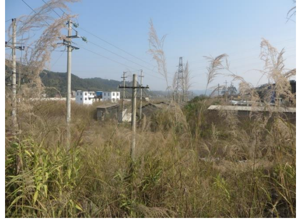
尚未清理的废弃施工生产区
