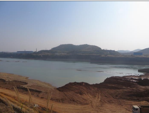
河道内的施工便道
