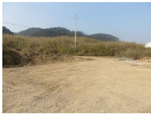
混凝土拌和系统
