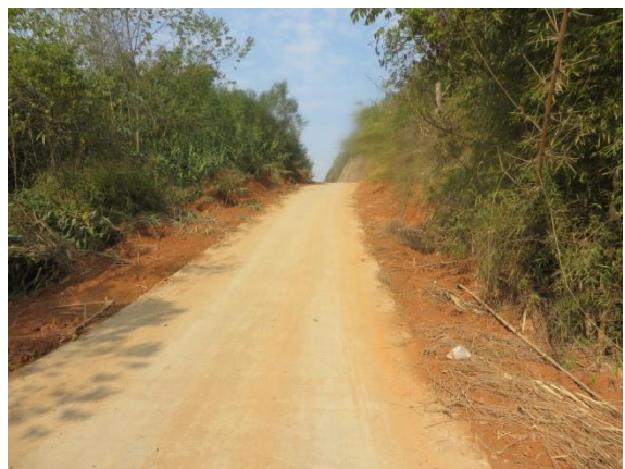
左岸施工便道
