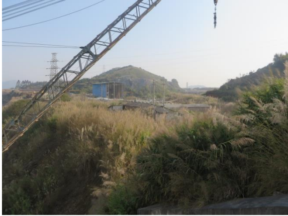
尚未清理的废弃施工生活区
