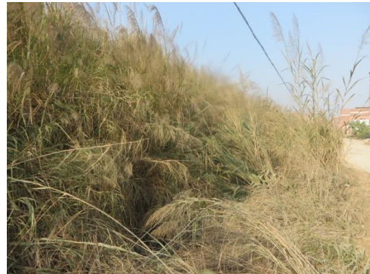
弃渣场无拦挡设施
