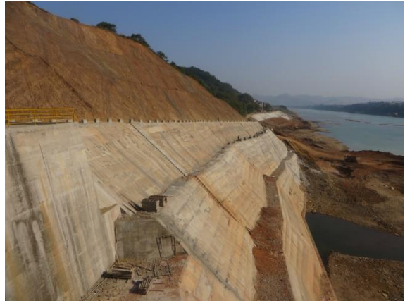
趋于完工的左岸下游边坡
