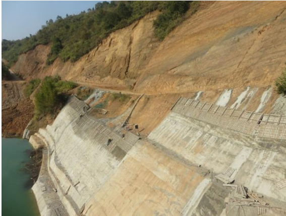
正在施工中的左岸上游边坡
