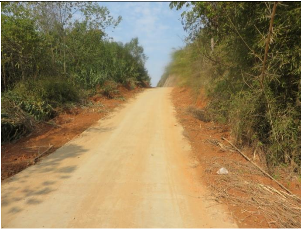
已硬化路面及两侧裸露地表
