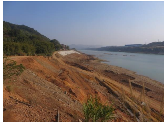
正在施工中的左岸裸露边坡
