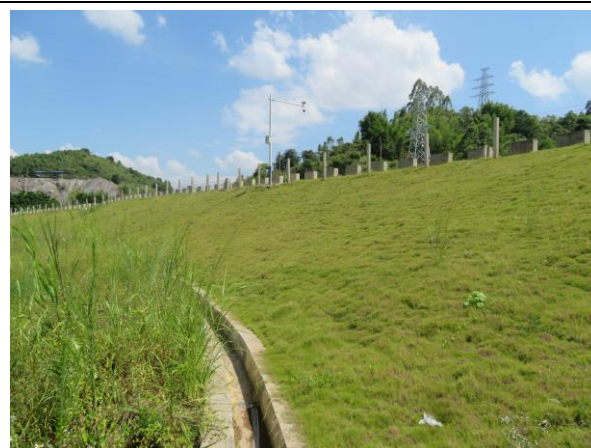
右岸进场道路（现状）
