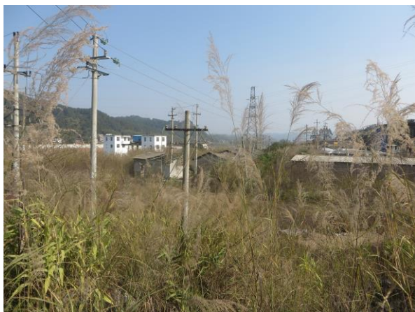
施工工厂及生活区（2015.1）
