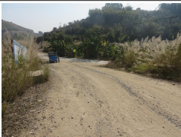
右岸进场道路（2015.1）
