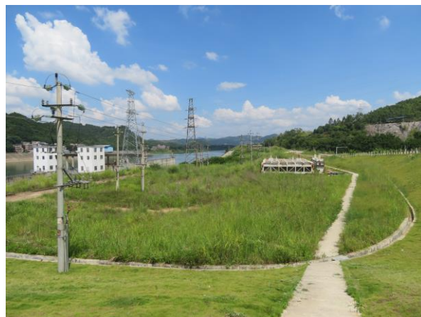
施工工厂及生活区（现状）
