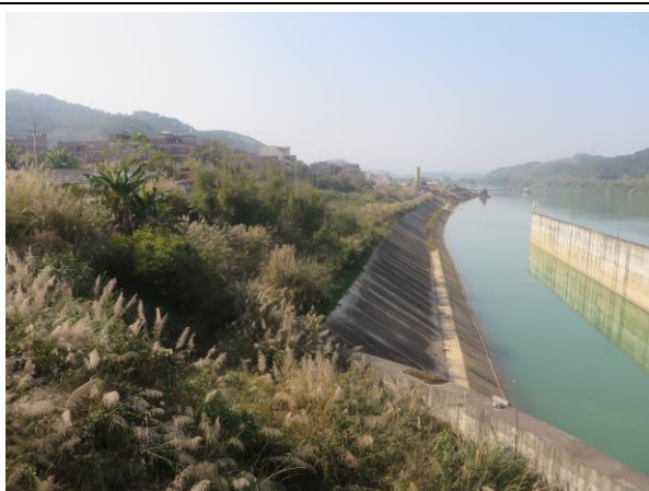
施工工厂及生活区（2015.1）
