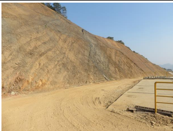
左岸施工道路（2015.1）
