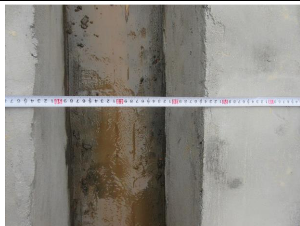
排水沟尺寸测量
