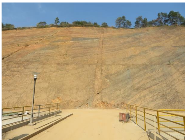
主体工程建设区左岸边坡（2015.1）
