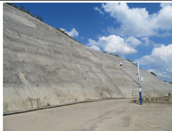
左岸施工道路（现状）
