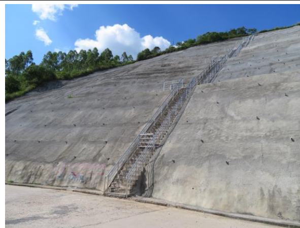
主体工程建设区左岸边坡（现状）
